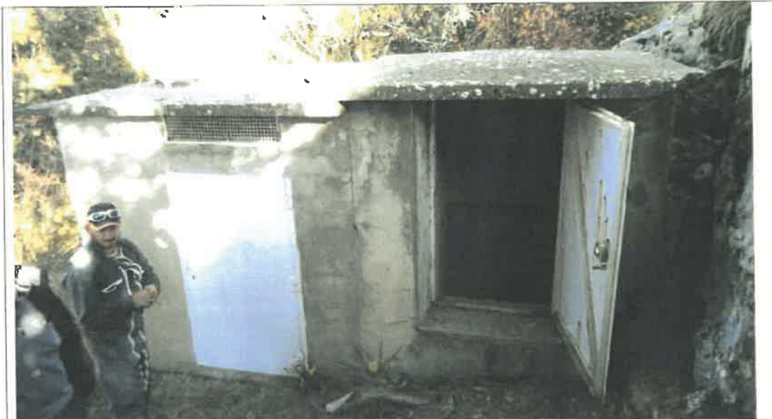
Vue extérieure de la chambre de captage.
