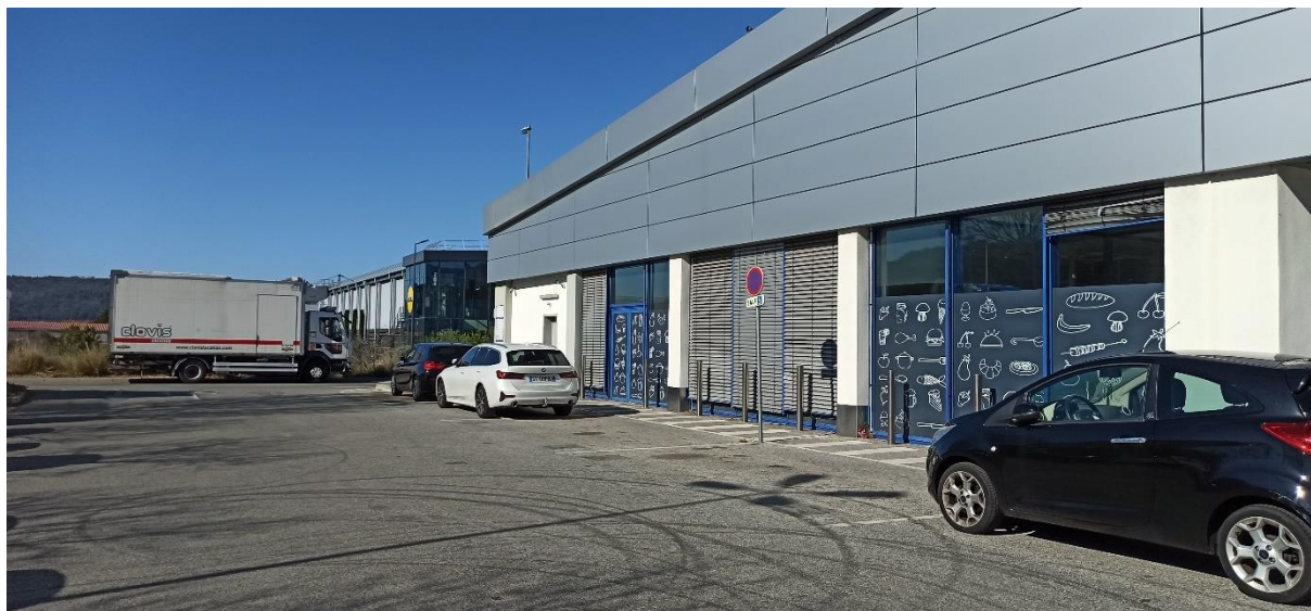
Photo 1 : Ancien LIDL présent sur le secteur d'étude (EVEN, Avril 2022)
