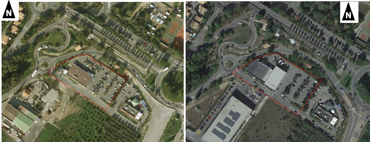
Figure 4 : Vue aériennes du secteur d'étude entre 2006 (gauche) et 2019 (droite) (Google earth)
