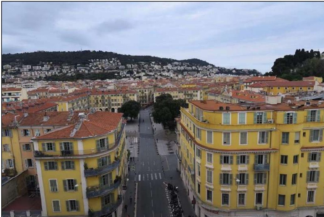
Vue sur les bâtiments bordant la zone d'étude et la place Garibaldi, depuis les toits du MAMAC - Photo : J. BARET
