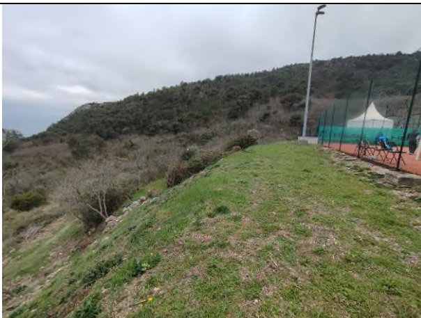
Talus de remblais aval tennis
