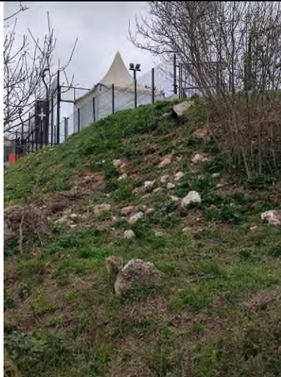
Talus de remblais aval tennis
