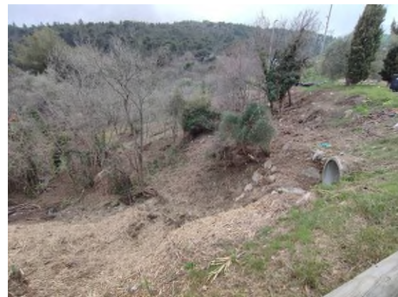
Talus aval chaussée
