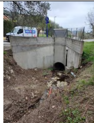
Partie amont de la buse du vallon
