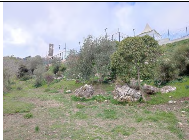
Talus de remblais aval tennis
