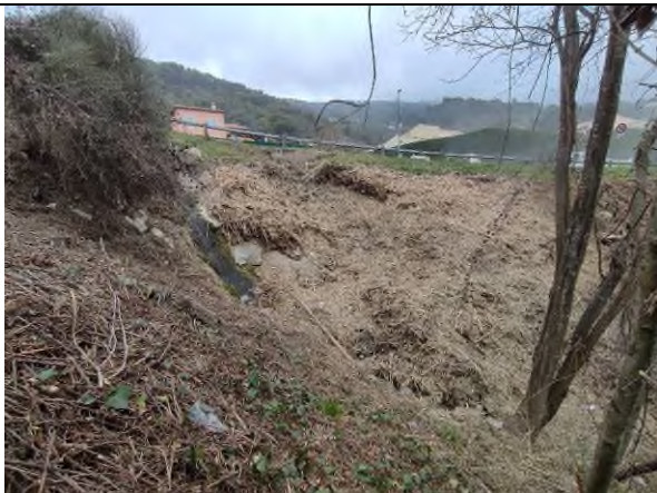
Talus aval chaussée
