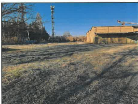
Antennes et bâti côté sud
