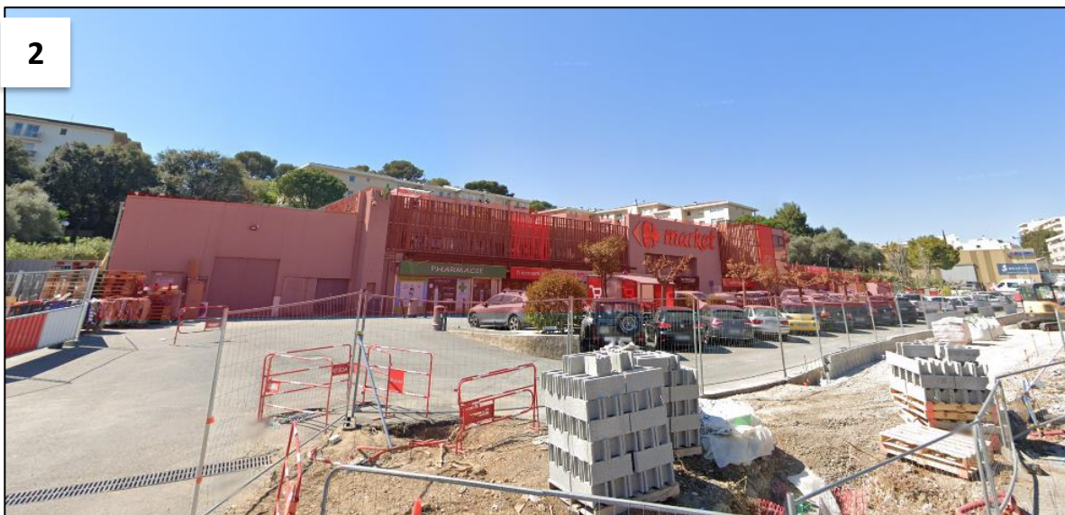
Figure n°1 et n°2 : prises de vue de la zone d'aménagement d'une partie des bâtiments du projet. En rouge : supermarché avec parking extérieur concerné par un permis de démolir en cours d'instruction
