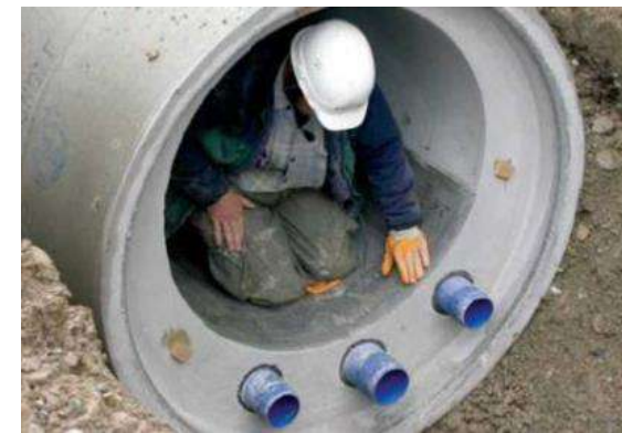
Figure 163 : Principe de fonctionnement de la récupération de chaleur des eaux usées sur les canalisations (Source : Susanne Staubli)
