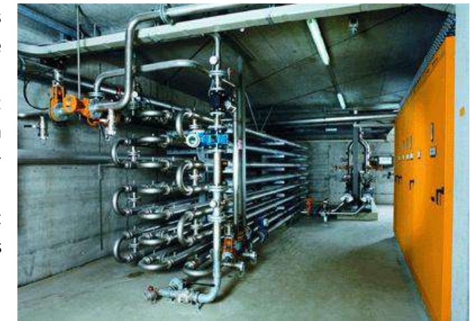
Figure 169 : Échangeur tubulaire en sortie de STEP (Lyonnaise des Eaux, ISTINOX, ANTEA)
