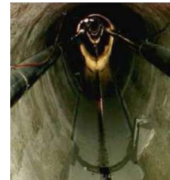
Figure 165 : Échangeur installé dans un ovoïde existant (Rabtherm), échangeur pour collecteur existant (Uhrig)
