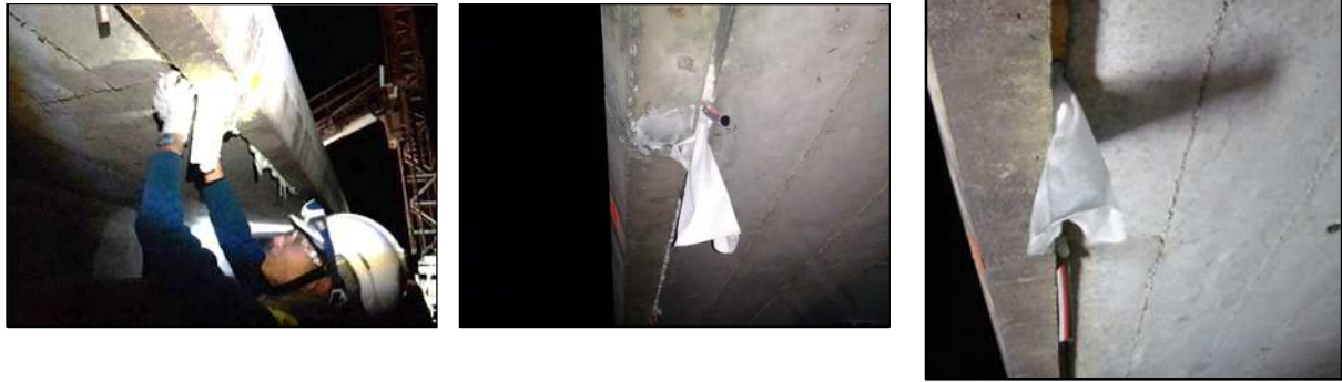
Matériel utilisé pour créer un SAR (en haut) et mise en place sur les fentes de l'ouvrage (en bas)
