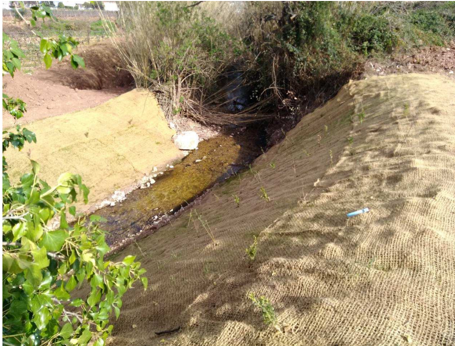
Berges du Meïge Pan (83) : Toile coco + ensemencement + plants en godet en cours de mise en œuvre
