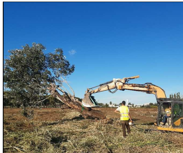
Abattage à l'aide d'une pelle mécanique et d'une tronçonneuse
