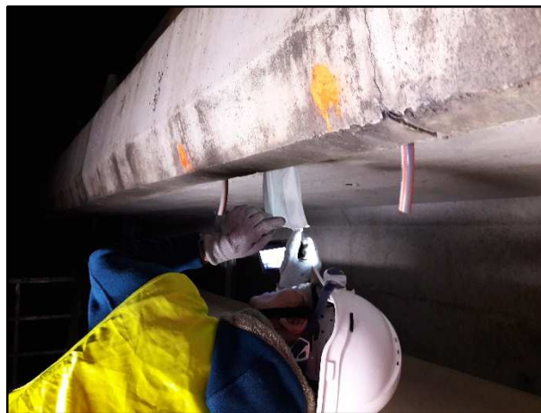
Vérification des SAR mis en place avant de les retirer
