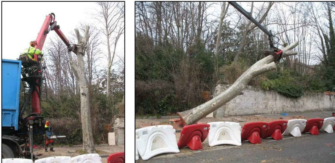
Exemple de dépose délicate d'un tronc creux au grappin hydraulique
