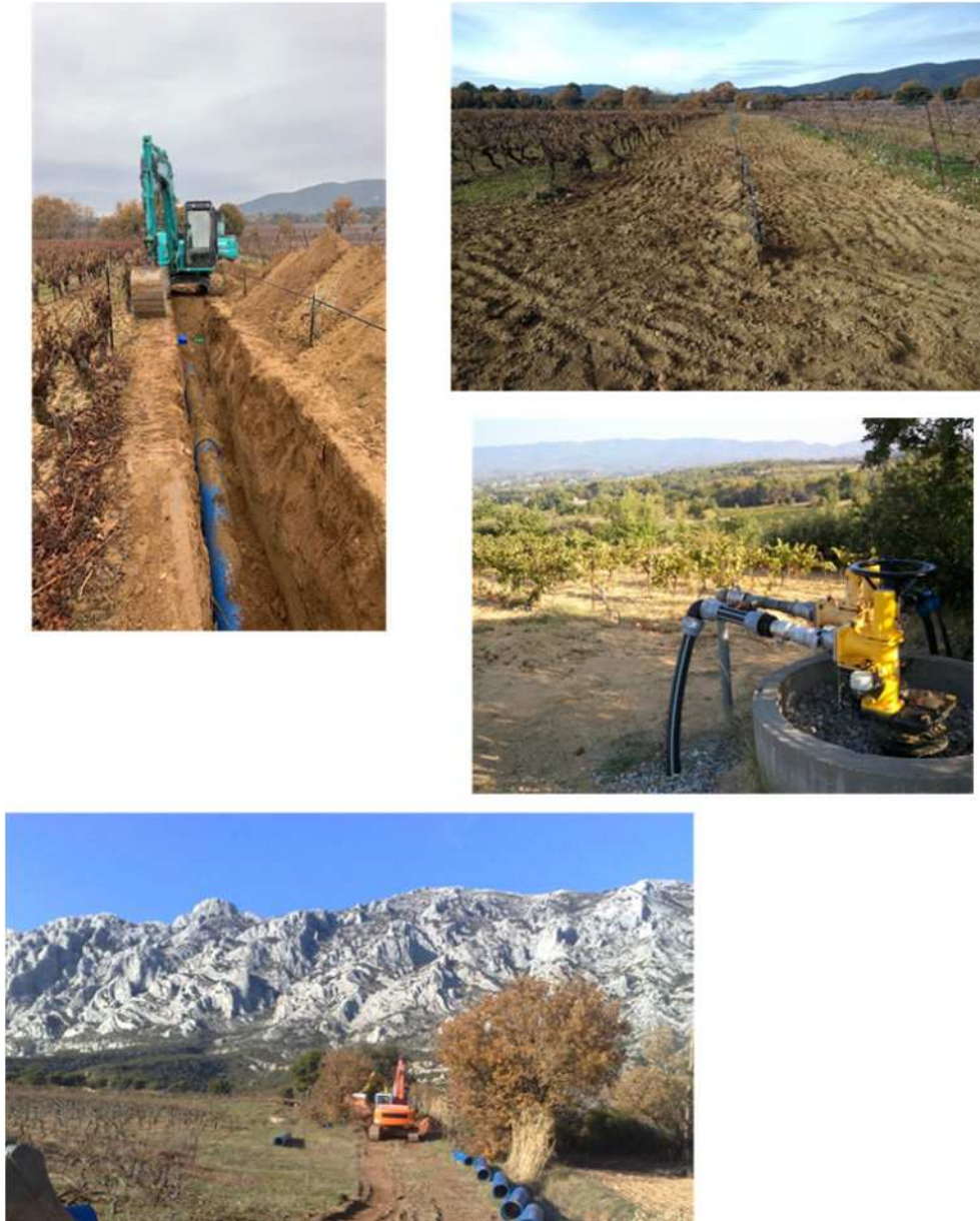
Figure 1 - Illustrations de chantiers de pose de canalisation
