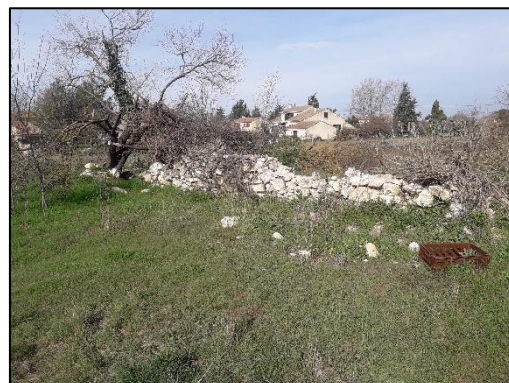
Muret résiduel au centre de la zone d'étude
