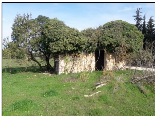
Ruine enfrichée à l'est de la zone d'étude
