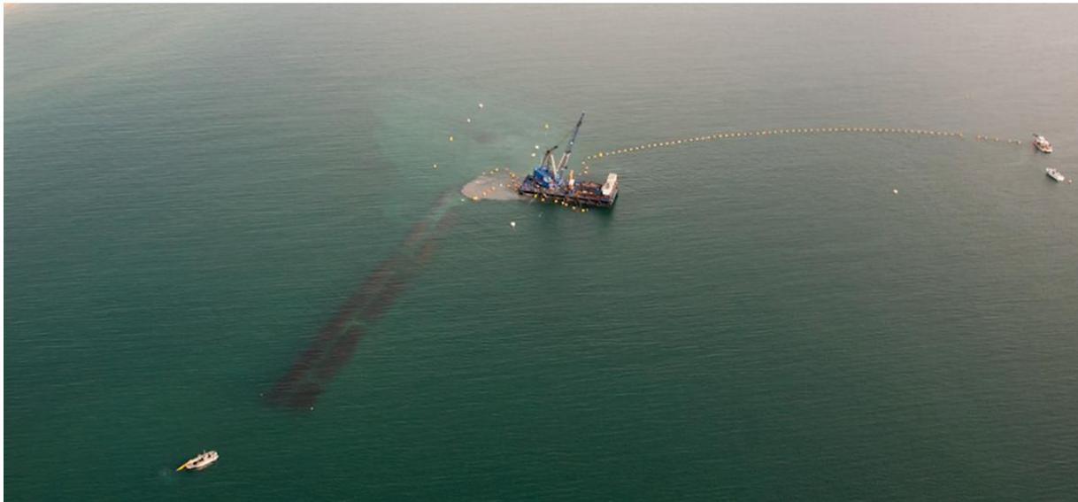
Figure 50 : Mise en place des Géotubes© au large de Sète (Hérault) – Source : TRASOMAR et Sète agglomération Méditerranée
