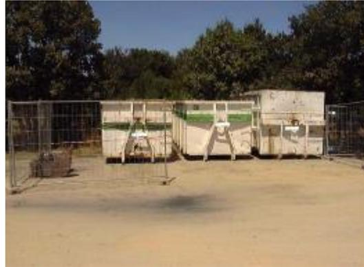
Figure 45 : Exemple de bennes destinées à accueillir les déchets de chantier
