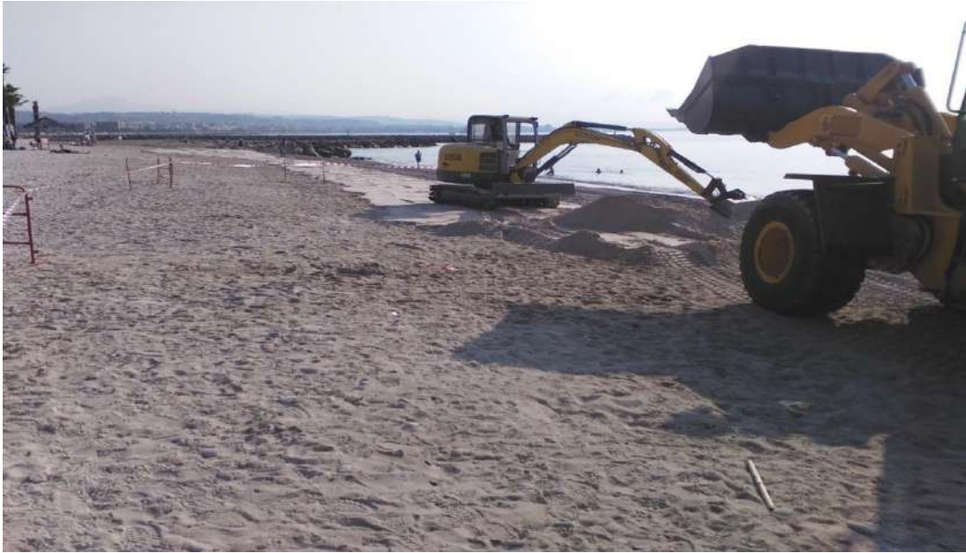
L'aide d'engins mécanique avec balisage de chantier
