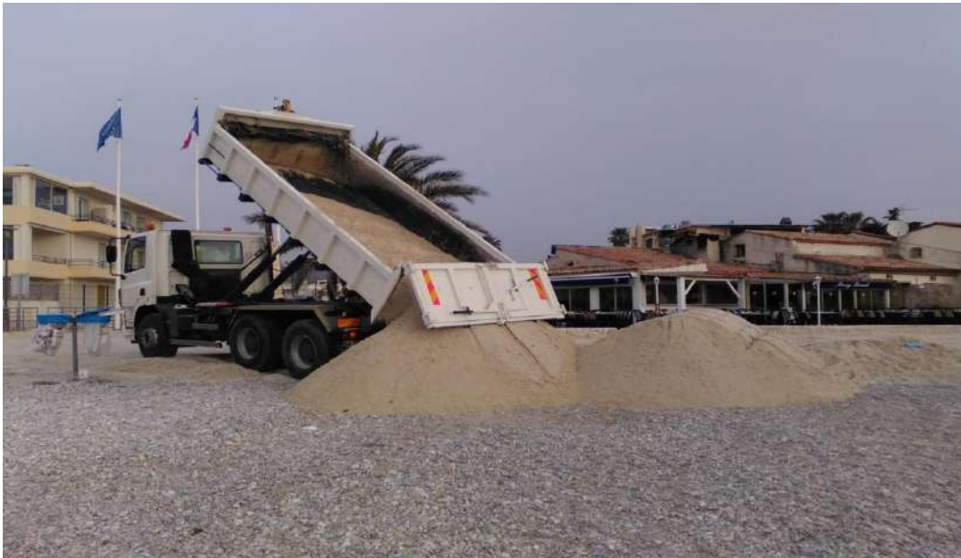
Livraison du sable par les camions
