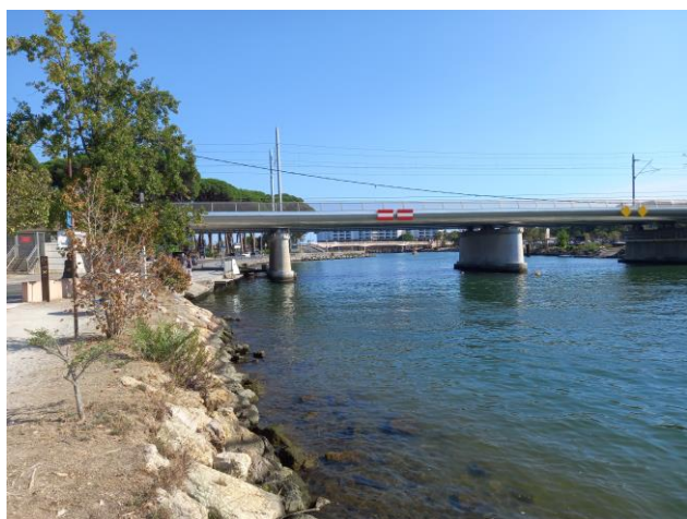
Vue du viaduc SNCF depuis l'amont
