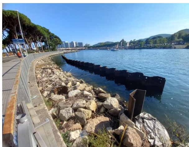
Zone de confortement (aval) avec rideau de palplanches existant
