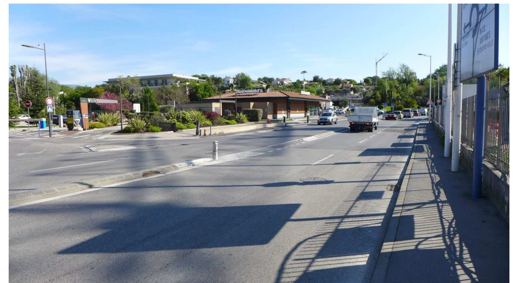
Tourne-à-gauche depuis la Route de France
