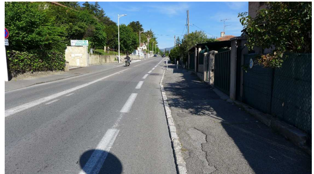
Bande cyclable le long de l'Avenue de la Colle (M6)
