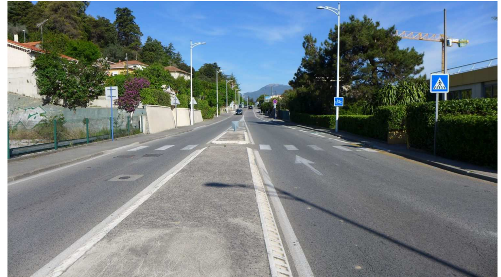
Avenue de la Colle (M6)
