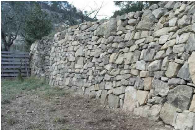
Murs de pierre sèche
