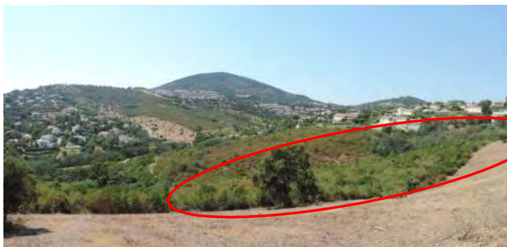
Vue de la zone 6 de transition entre les zones 7 et 8 – 12 juin 2017
