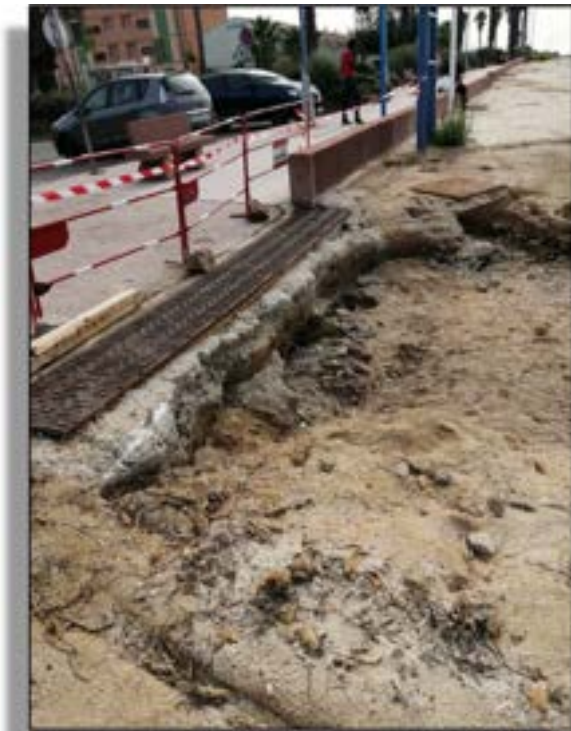
Curage et nettoyage des grilles d'évacuation, remplacement pour de plus grandes, si nécessaire
