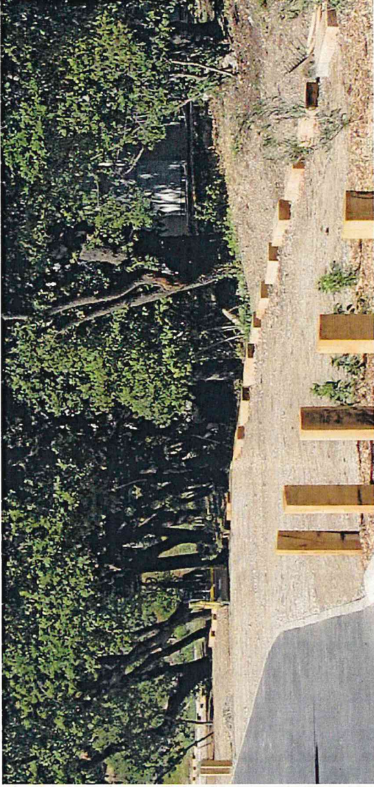
Exemple de parking en mélange terre-pierre à Luminy sans chaux.
