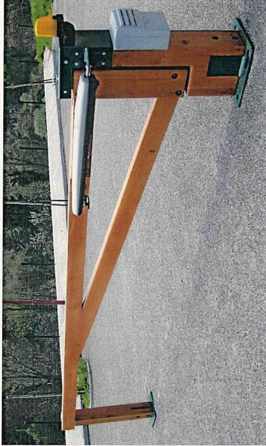
Type de barrière bois pivotante avec moteur pour l'accès au parking des professionnels de Carajuan (2 barrières)
