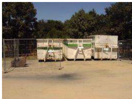
Figure 20 : Exemple de bennes destinées à accueillir les déchets de chantier
