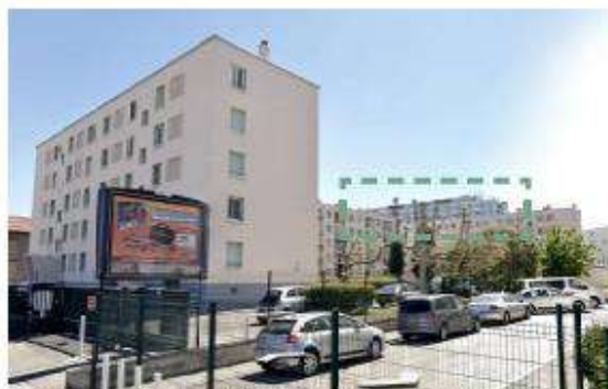
Vue du site depuis le boulevard Romain Rolland
