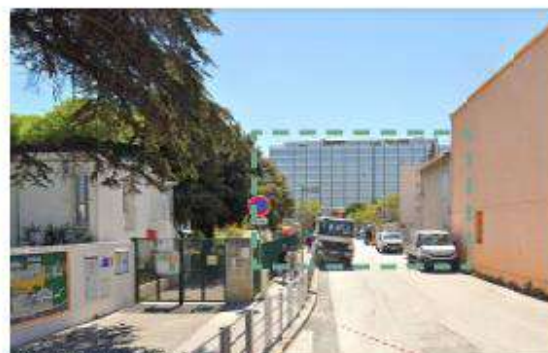
Vue de la voie d'accès au site
