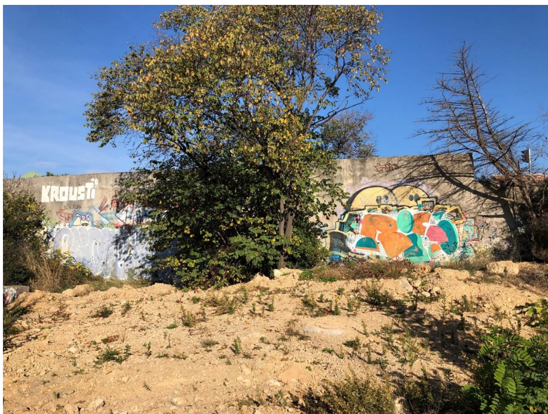
Photographie du mur 1
