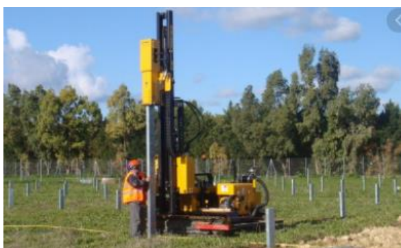
Figure 3. Ancrage des pieux battus
