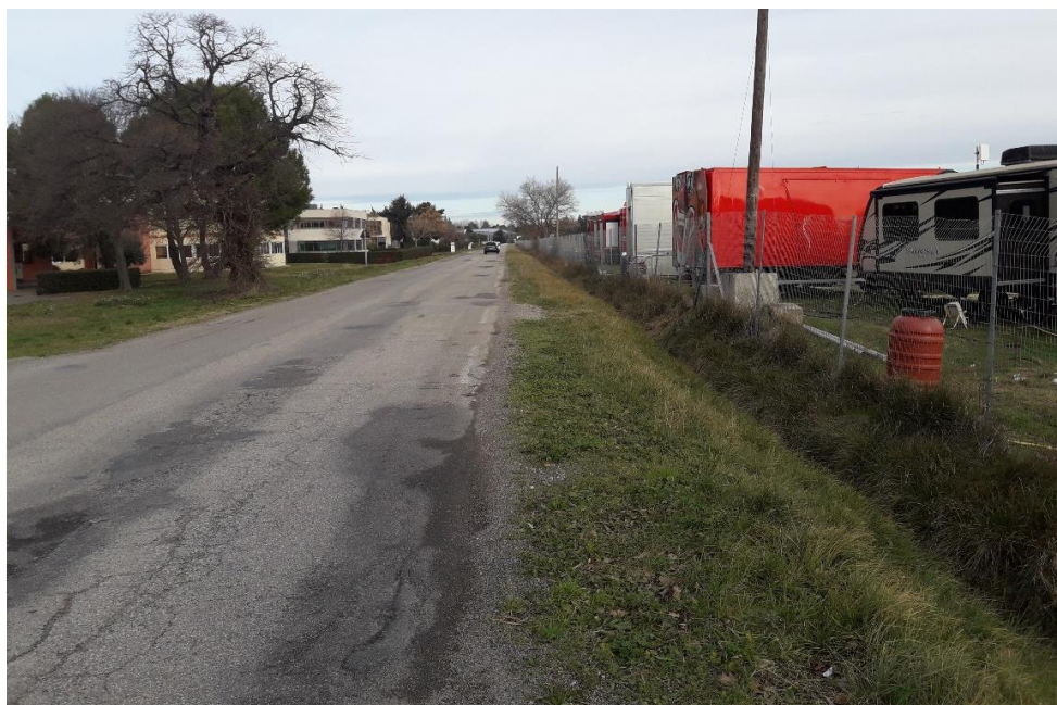
Aperçus de la zone d'étude (à droite), et du fossé longeant le chemin des Férons
