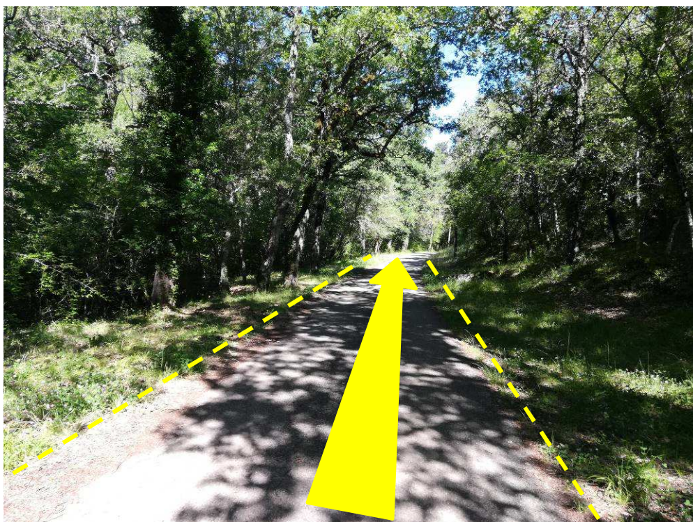
Figure 4 Pose du réseau sous la chaussée de l'allée Didier Blain
