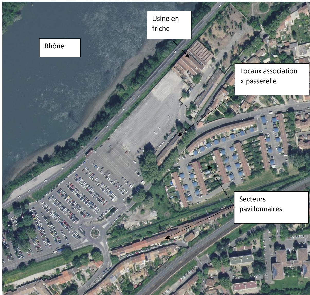
Prise de Vue aérienne (septembre 2020)
