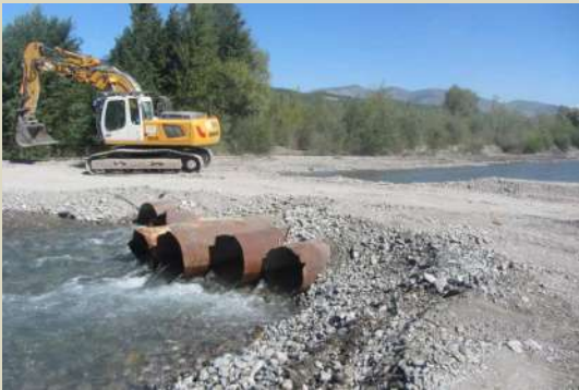
Exemple de busage temporaire mis en place sur la Bléone en 2013 sur le chantier de confortement de la digue du Gibassier au Chaffaut (SMAB)
