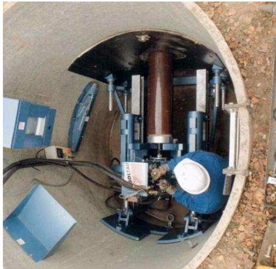
Figure 8 : Exemple de puits de travail pour un micro tunnelier de DN 150 à DN800 (source : <http://www.pentes-tunnels.eu> ; R-M Faure; M. Ghouari).
