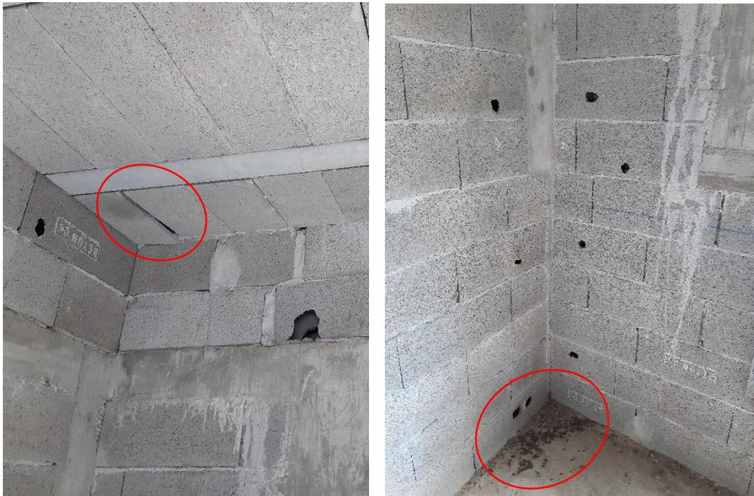
Figure 18 : fissures au plafond avec guano au sol, Mathilde GARRIONE © EODD 2020
