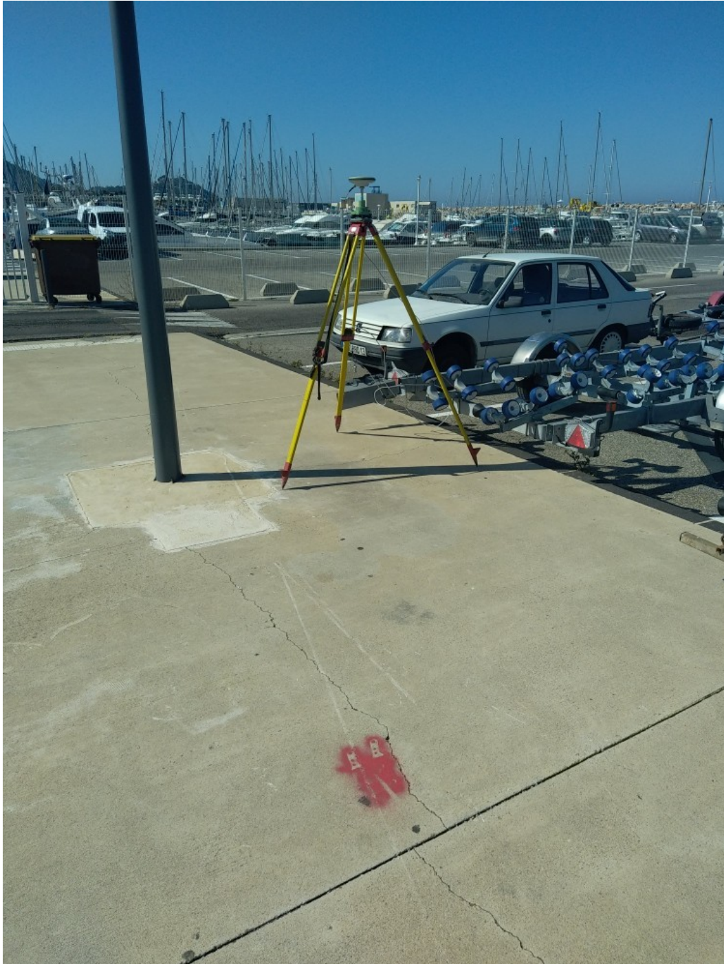
Figure 3 : Installation de la base de référence
