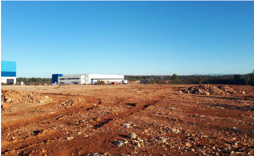
Photographie n° 3 : Vue rapprochée sur la plateforme depuis la façade Est (COLAS MM, 13/02/2019)
