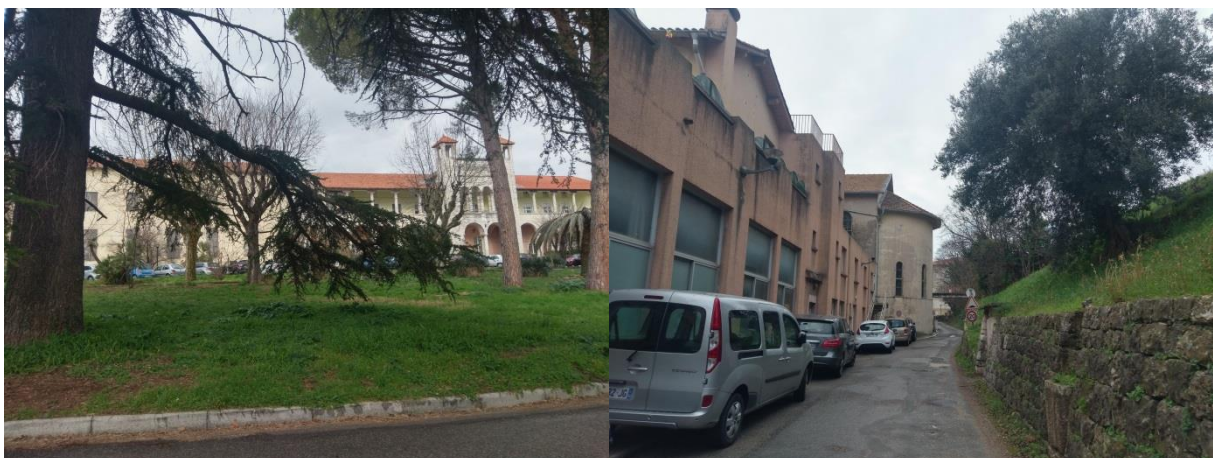
Photo 2 : Bâtiment central dans le secteur d'étude, dont la façade sera conservée : vue de face et vue de l'arrière (Even, Janvier 2019)
