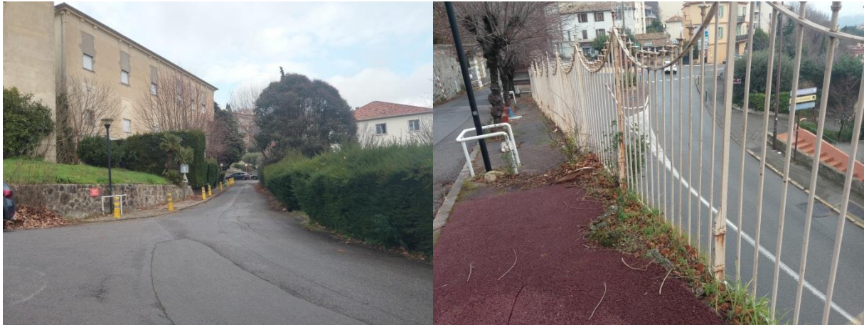
Photo 9 : De gauche à droite : voie d'accès au nord du site et vue sur l'avenue de la libération depuis l'entrée du secteur d'étude (Even, Janvier 2019)
