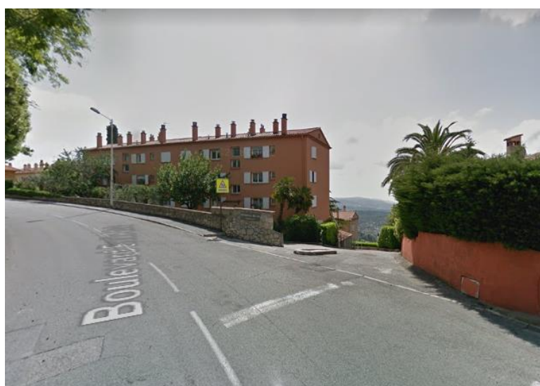
Figure 16 : Vue sur les résidences collectives au nord de la zone d'étude (Google Earth)
