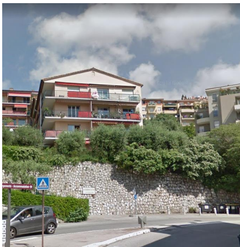
Figure 15 : Vue sur des résidences collectives à l'est de la zone d'étude (Google Earth)
