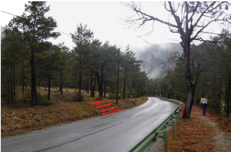
Principe de traversée piétonne : glissière interrompue, marches en bois, pas de marquage sur la chaussée.
