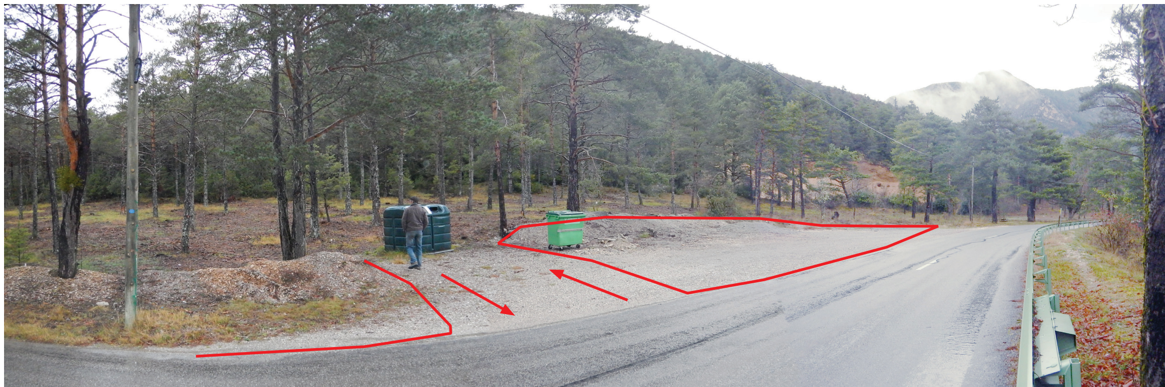
Entrée / sortie proposée d'une largeur de 10 m, axe perpendiculaire à la route. Espace cerclé de rouge à renaturer, fossé à décaler le long de la route. Les futurs conteneurs à déchets seront supprimés et remplacés par la CCAPV, côté camping.
