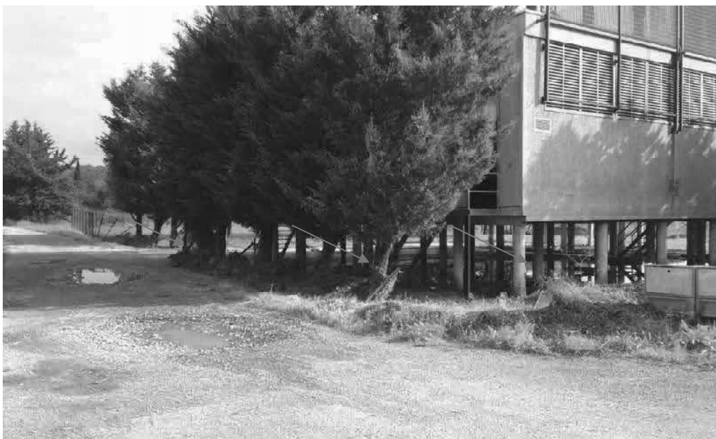
Figure 16 : Stagnation des ruissellements sous le bâtiment sur pilotis
