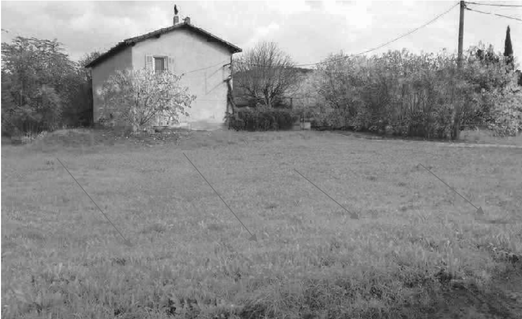
Figure 17 : Habitation de la parcelle B construite sur remblai
