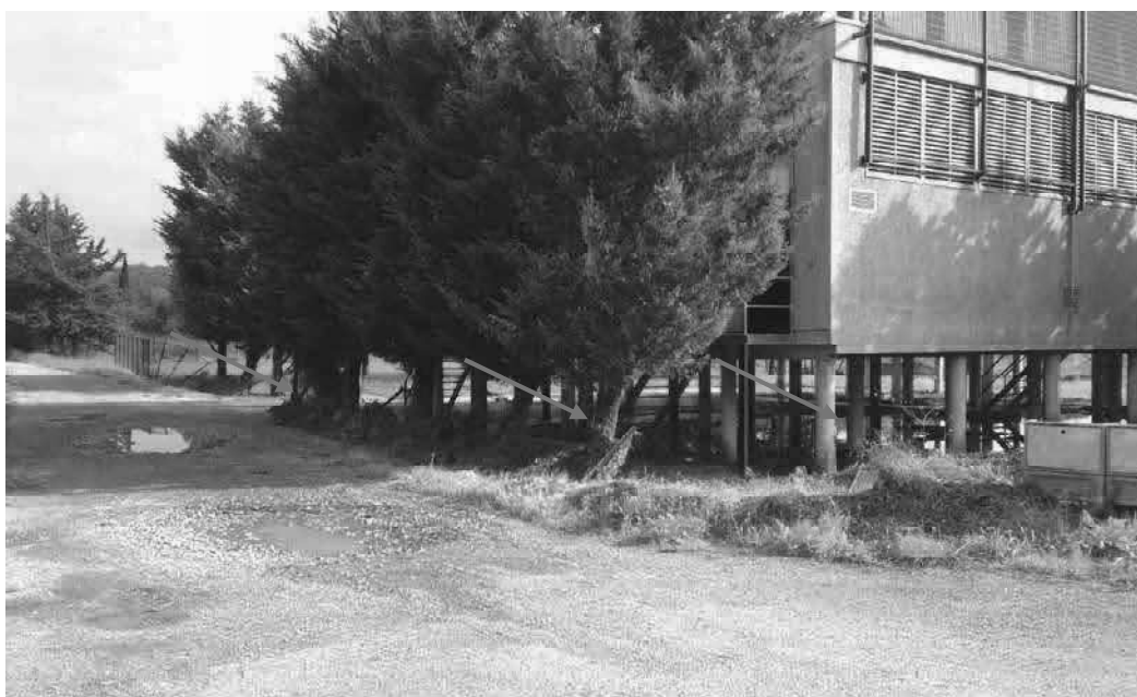
Figure 25 : Stagnation des ruissellements sous le bâtiment sur pilotis
