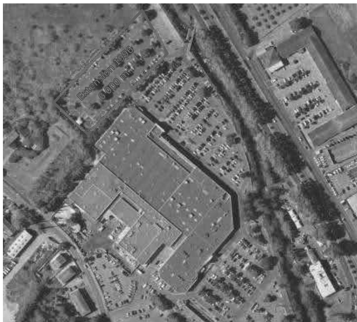
Figure 6 : Etat actuel des installations
