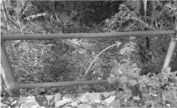
Figure 18 : Franchissement nord de l'ancienne voie ferrée
