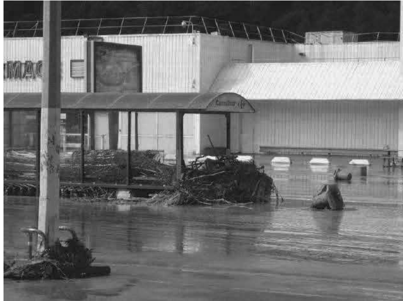
Figure 35 : Laisse de crue en juin 2010 sur le parking Carrefour (archive Trans-en-P ce )
