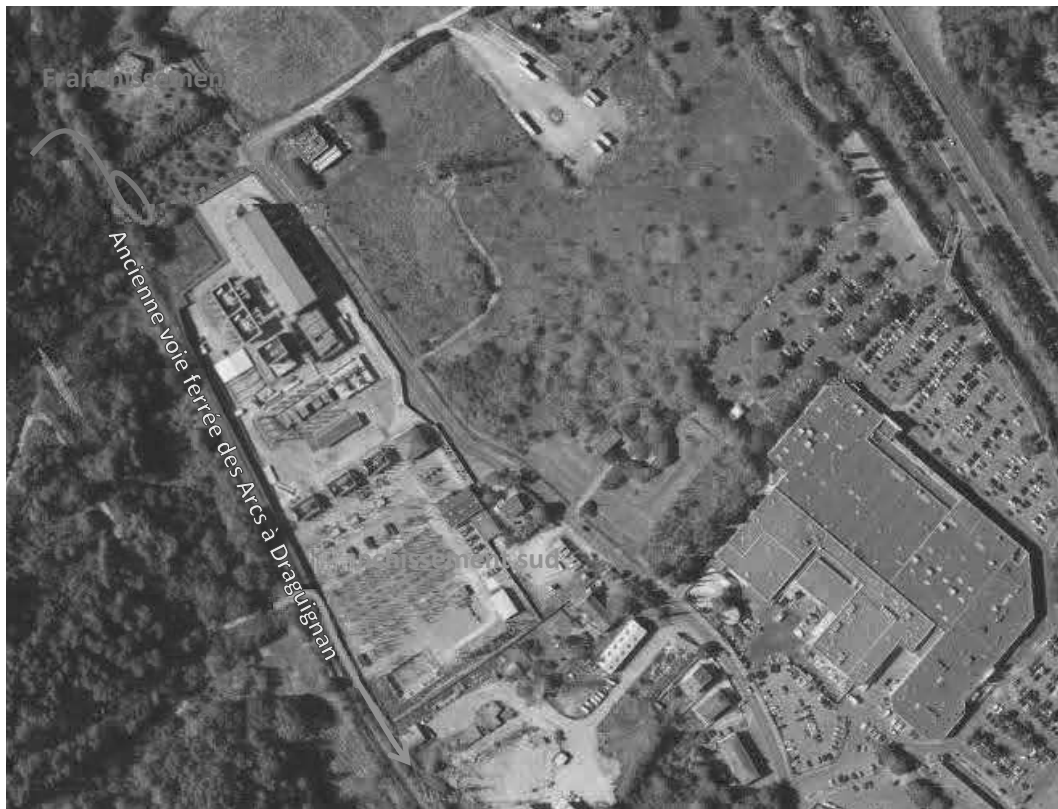
Figure 20 : Localisation des franchissements du talus de l'ancienne voie ferrée
