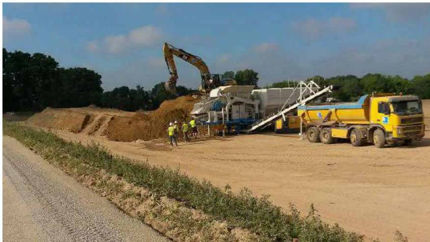
Figure 10 : Vue générale: dépôt provisoire et centrale de traitement mobile (chantier du Vidourle juillet 2015 - photo DigueELITE)
