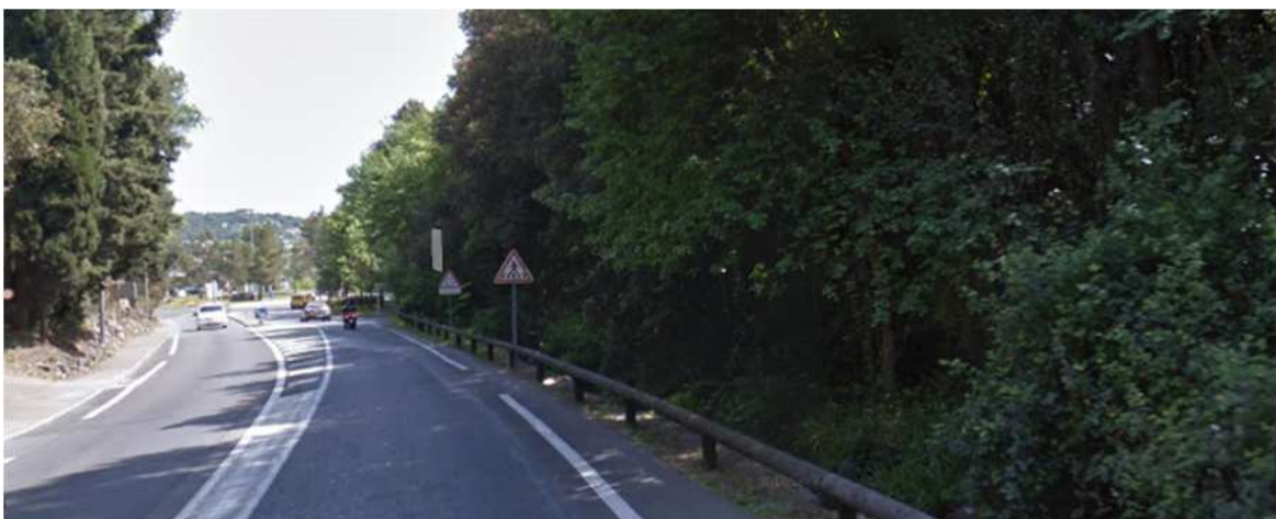
Figure 7 : Avenue Emile Hugues en amont de la déchetterie
