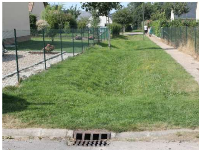
Figure 12 : Exemple de noue
