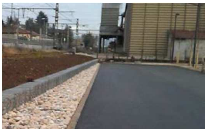
Figure 13 : Exemple de tranchée drainante
