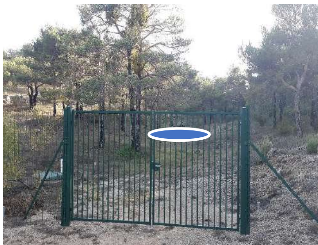
Le site de Ravel vu de l'extérieur ; l'enceinte grillagée matérialise le périmètre de protection immédiate et localisation du futur forage
