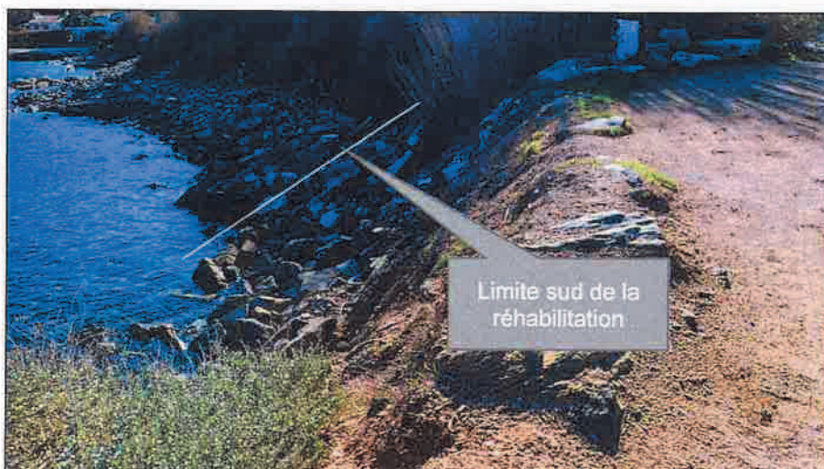
Photo n°1 – Limite sud du linéaire de digue à réhabiliter - ICTP juin 2018
