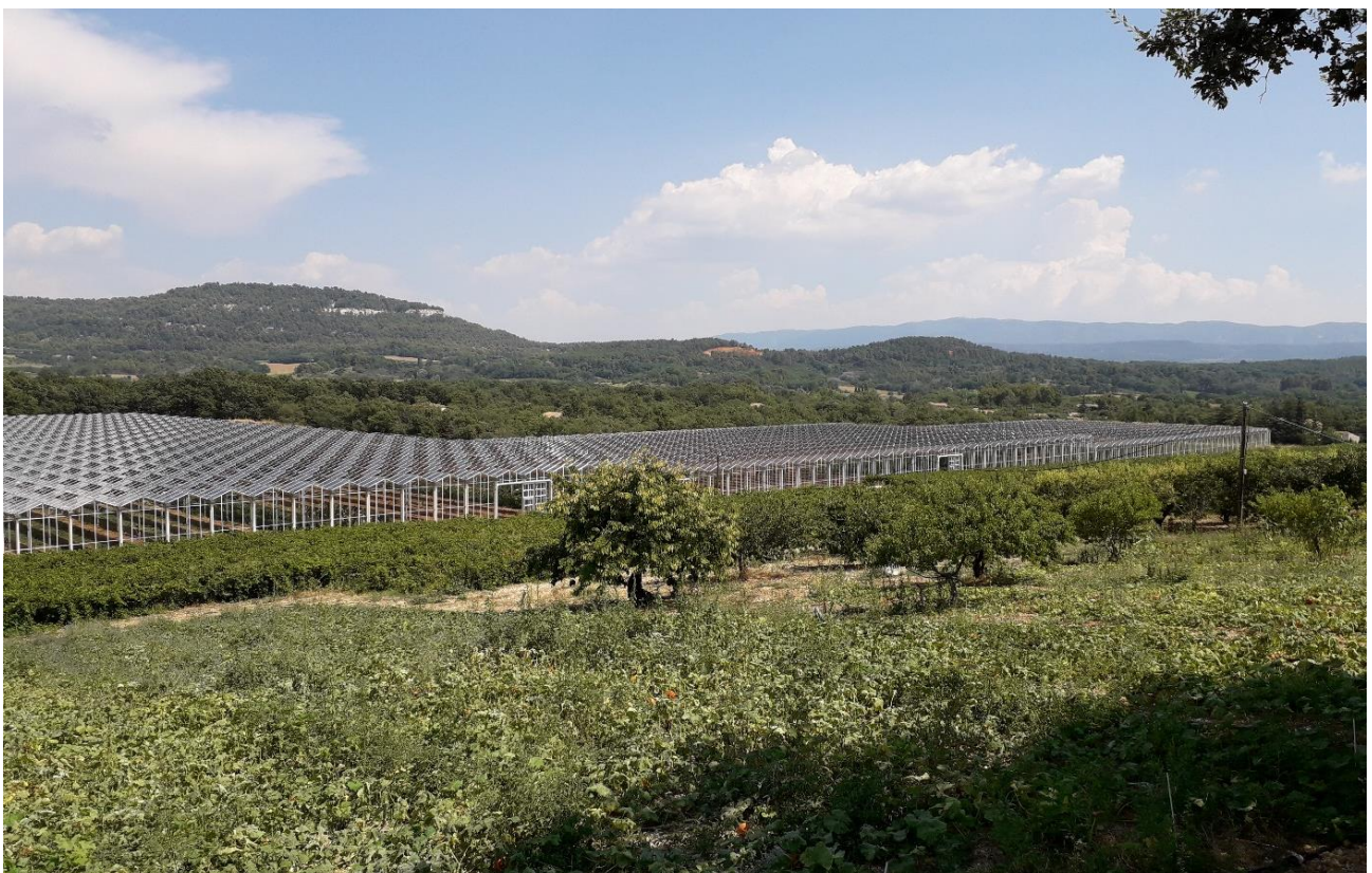
Figure 10 : Vue sur une partie de l'exploitation : serre agricole photovoltaïque, vigne et cerisiers. Prise de vue Reden Solar le 26/07/2018.
