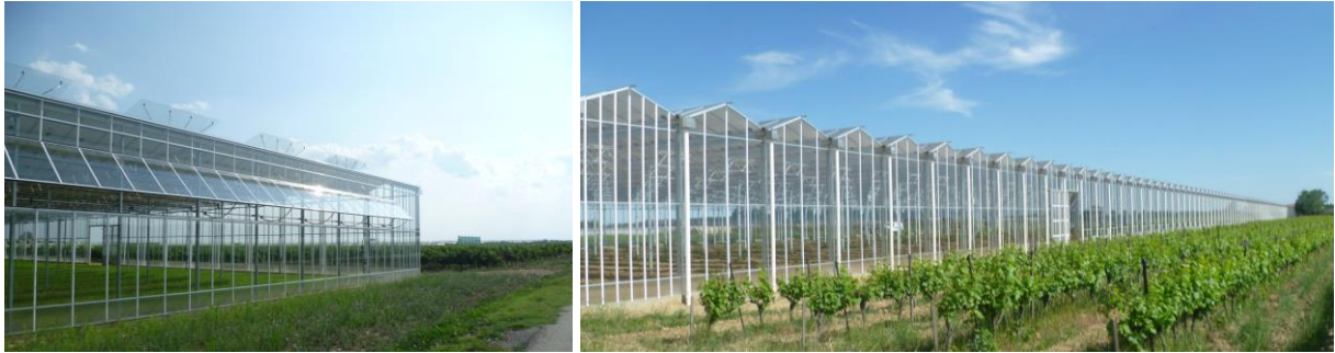
Figure 15 : Vue ouvrants en façade Nord et vue façade Est.
