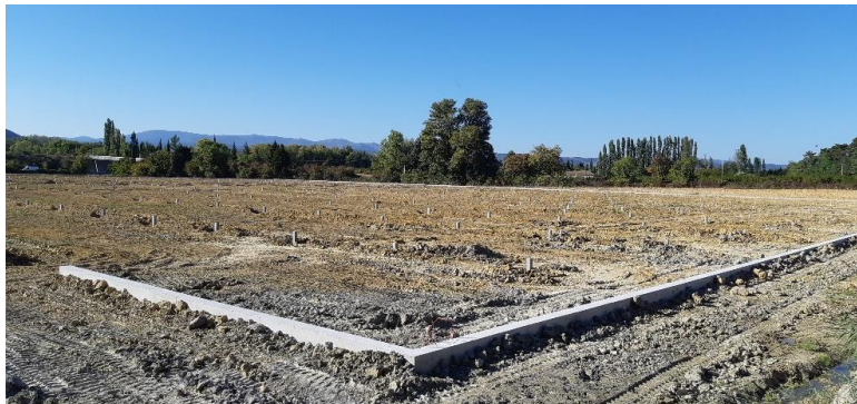
Figure 16 : Exemple de fondations béton extérieures. Prise de vue Reden Solar.
