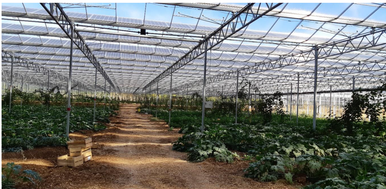
Figure 1 : Serre agricole photovoltaïque de Mr Ludovic Augier. Prise de vue Reden Solar le 03/10/2018.
