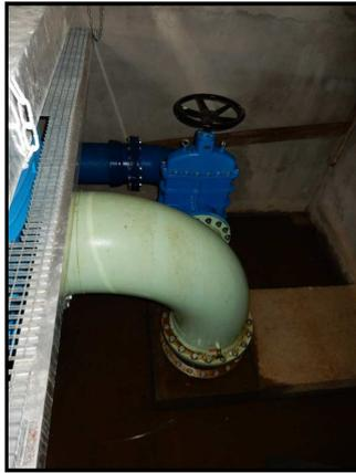
Photo 3 : Vue sur le coude boulonné sur la bride propriété d'EDF.
