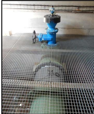
Photo 4 : Au premier plan, la manchette de stabilisation du régime hydraulique suivi de la manchette de comptage électromagnétique lui-même suivi d'une autre manchette de stabilisation du débit puis d'un Té à tubulure bride verticale sur laquelle est posé la vanne en DN 150 mm puis la ventouse.
