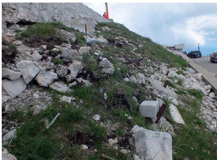
Pelouse du talus haut à restaurer
