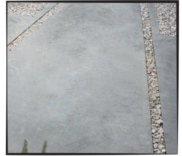
Interstices minéraux «érosion» (référence)
