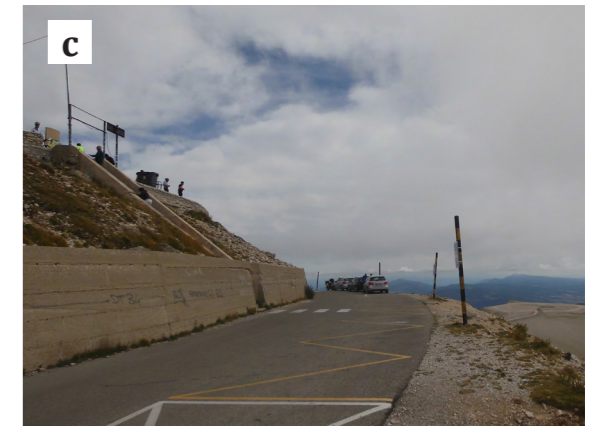
c L'arrêt de bus : Le stationnement est bien intégré et simple, le mur de béton soutenant le parvis est très peu esthétique, ainsi que l'abri-bus.
