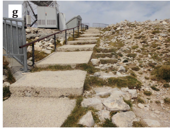
g Accès à la rotonde : Dégradé, illisible, déconnecté de la route, revêtement et main-courante distonnants, traces du pas d'âne en pierre
