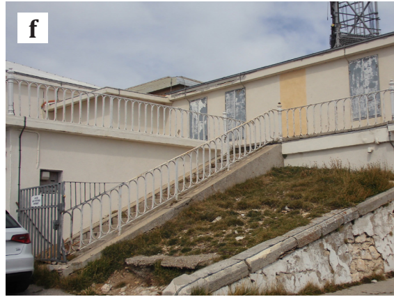
f La terrasse au-dessus de la boutique : Un espace de qualité avec un garde-corps travaillé, patrimonial (cf. celui de la rotonde) non valorisé
