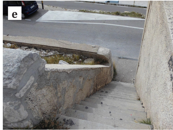
e L'escalier : Difficile à emprunter, dégradé, très pentu, débouchant au niveau de l'arrivée créant conflit avec les cyclistes.
