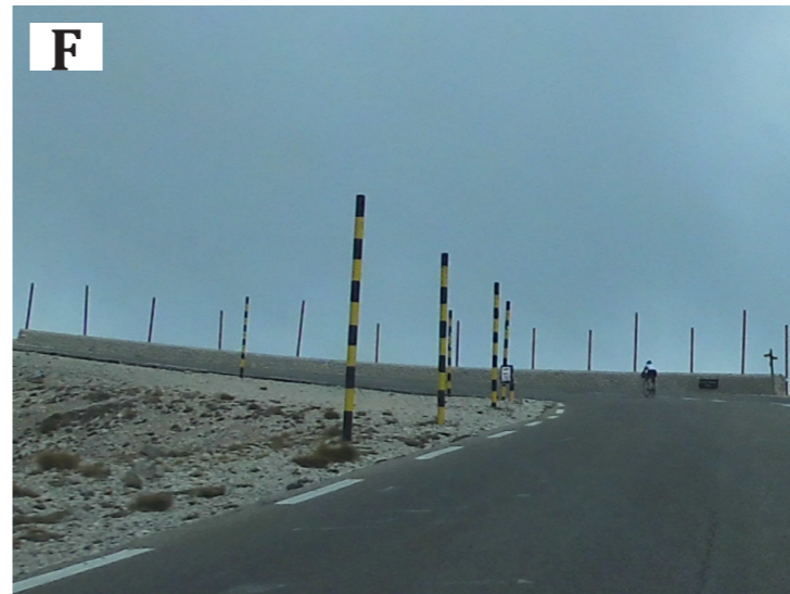
F Virage à la crête du Levant : muret de pierre à la fois protecteur et perturbateur de la nudité des lieux, toujours les piquets.
