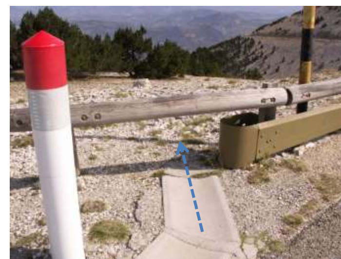
Photo 10 : Evacuation des eaux de ruissellement de la chaussée au niveau du bassin versant de la source du Rieufroid
