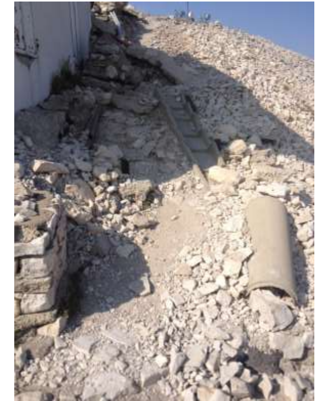
Evacuation des eaux pluviales totalement dégradée A cause des passages des piétons causant une déstructuration du pierrier par éboulis
