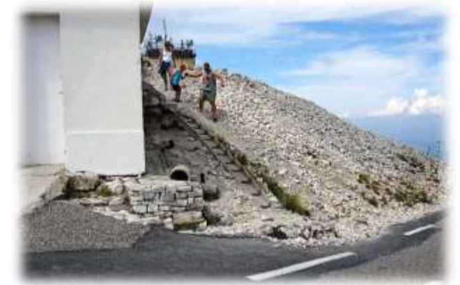
Absence de cheminement piéton et évacuation de EP en mauvais état
