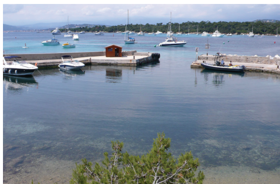
Fig. A•5 - 2018, port-abri vu du sud
