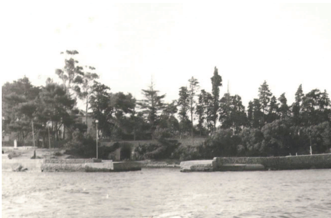
Fig. 21 : détail du document précédent On peut observer sur cette photographie que les deux digues construites en 1893 ne sont pas encore protégées à l'extérieur par des enrochements
