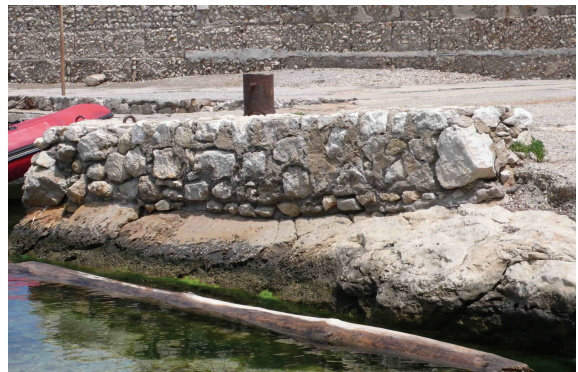
Fig. C•43 - Muret en retour élevé sur le rocher (© CPA)
