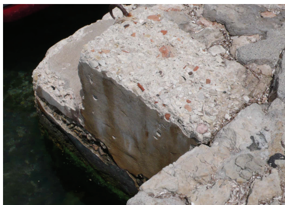
Fig. C•41 - Consolidation de l'extrémité du quai (© CPA)
