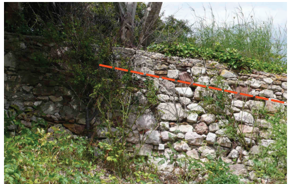
Fig. C•11 - Rehausse du muret (© CPA)
