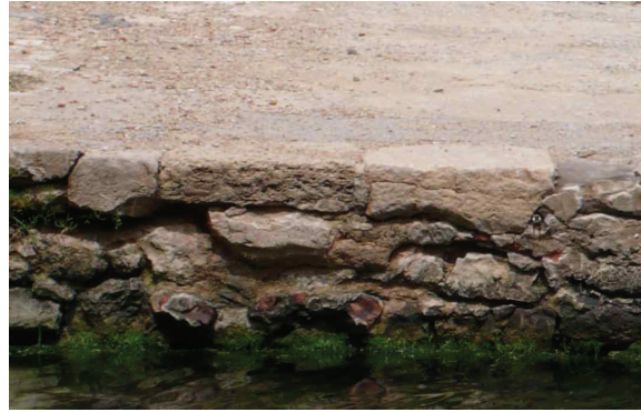
Fig. C•19 - Rive traitée en gros blocs (© CPA)
