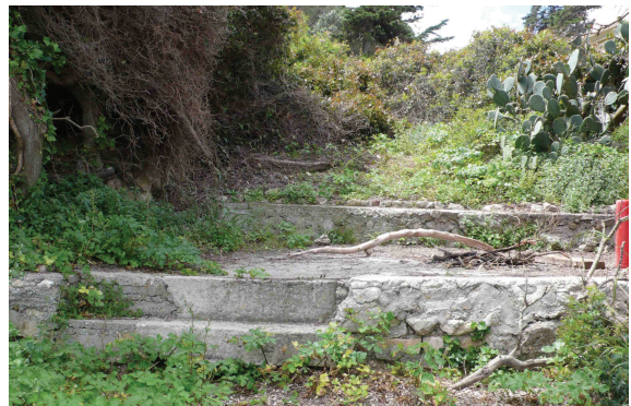
Fig. C•9 - Ressauts au sud du muret (© CPA)
