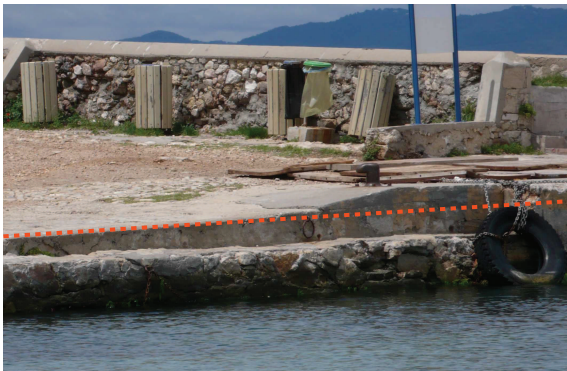
Fig. C•15 - Trace de l'inclinaison du quai (© CPA)
