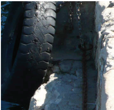
Fig. C•20 - Organeau forgé, scellé sur la face du quai (© CPA)
