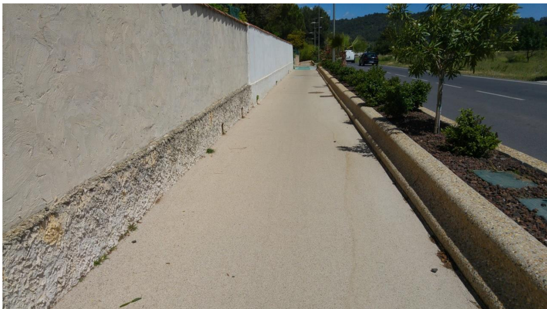
Figure 37 : Bande cyclable à la sortie d'agglomération de La Crau le long de la RD29
