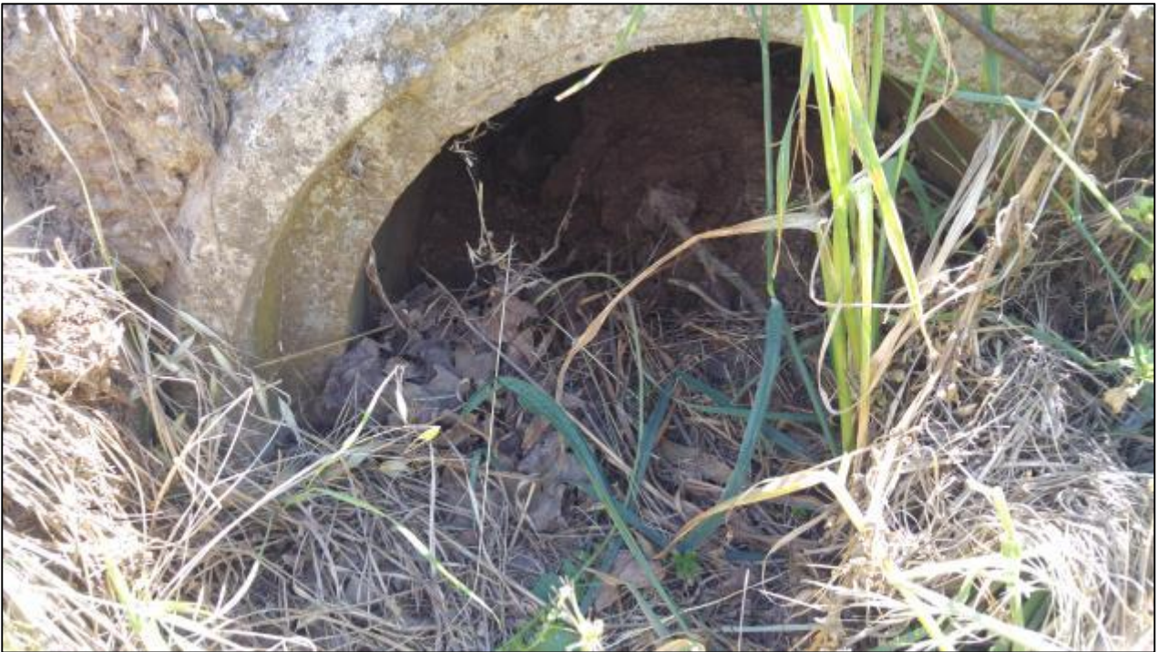
Figure 13 : La majorité des ouvrages hydrauliques situées sous les voies d'accès aux propriétés privées sont soit sous-dimensionnés soit mal entretenus
