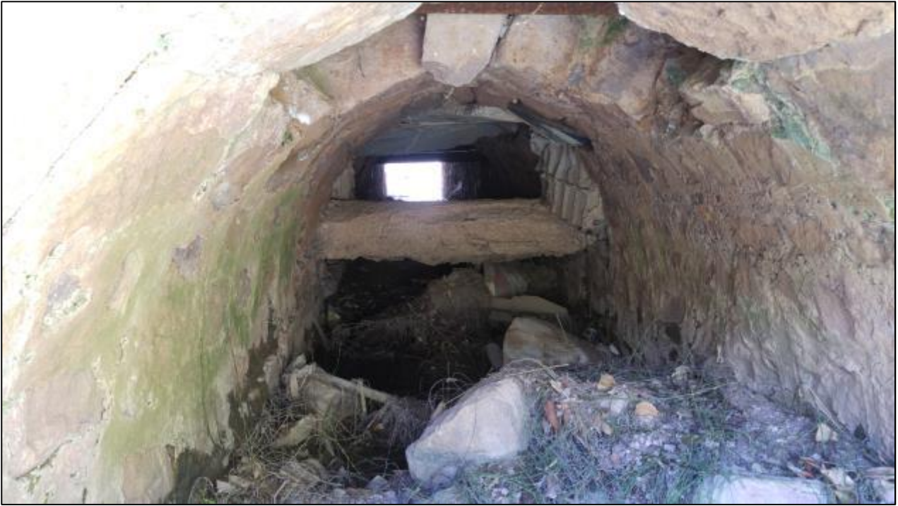
Figure 12 : Cadre béton sous la RD29 suivi d'un ancien pont arche et des obstacles visibles
