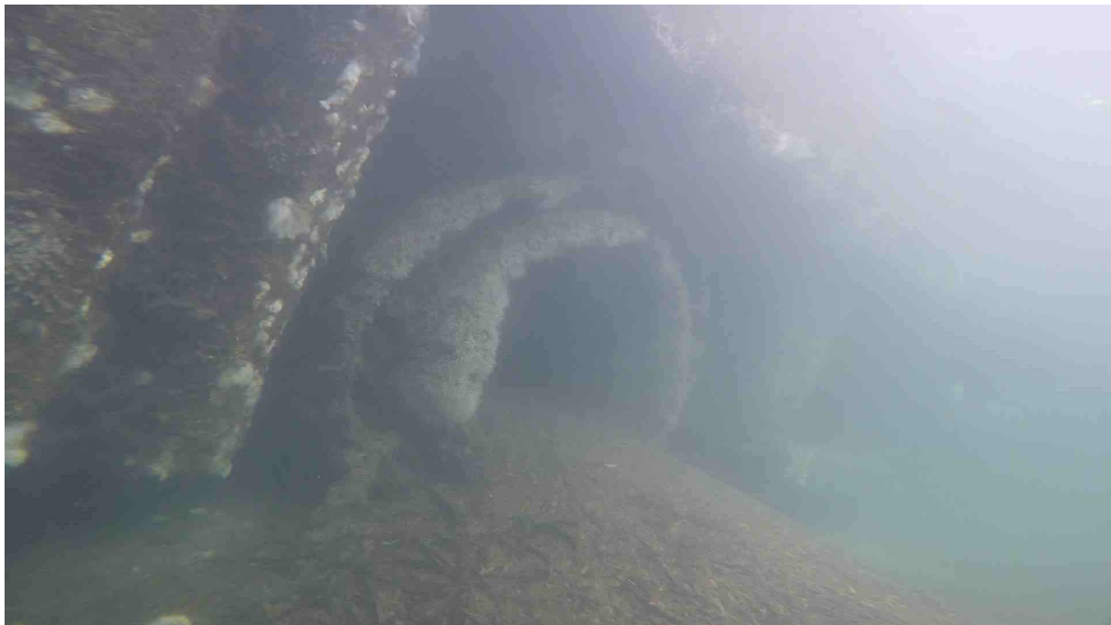
Palplanches entourant la sortie de buse existante
